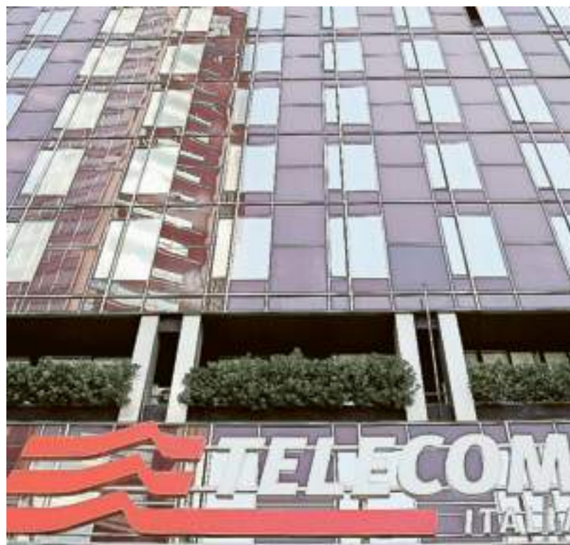
Il quartier generale di Telecom Italia, a Milano
